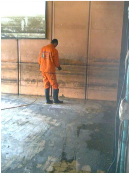
Aplicación de EM en mezcla con agua
