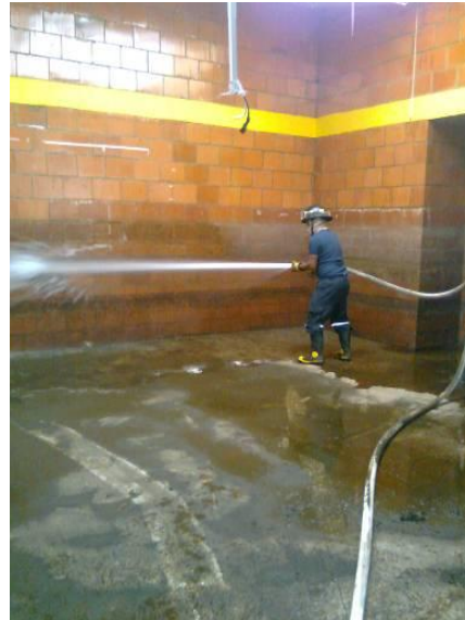
Apoyo de Bomberos para lavado a presión
