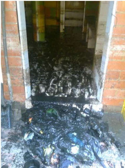
Aplicación de EM antes de retirar los sedimentos
