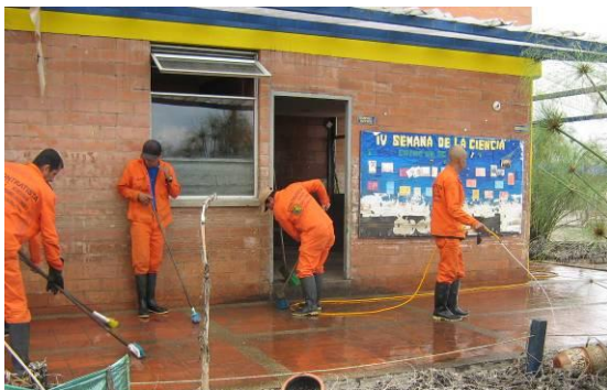
Labores de reacondicionamiento
